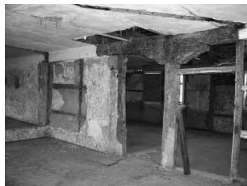
3 Bad Langensalza, Bergstr. 15, ehemaliger Saal. Bereits 1534 sind im Saal erste Unterteilungen nachweisbar. – Bad Langensalza, 15 Bergstrasse : l'ancienne salle a été divisée dès 1534.
