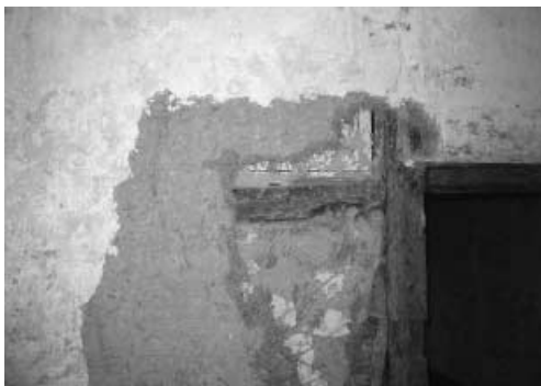
6 Bad Langensalza, Bergstr. 15. Farbfassung als Begleiter mit Ritzer (hier im Obergeschoß). – Bad Langensalza, 15 Bergstrasse : peinture d'origine au premier étage.
