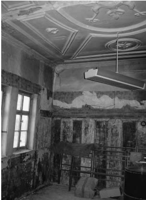
9 Bad Langensalza, Bergstr. 15. Stuckzimmer nach Freilegung der ersten Bohlenstube (Ständerbohlenbau). – Bad Langensalza, 15 Bergstrasse: plafond en stuc, état après restauration.
