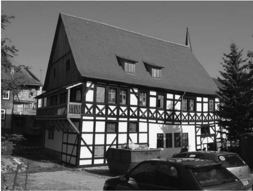
13 Bad Langensalza, Bergstr. 15. Südansicht nach Sicherungsarbeiten 2006. – Bad Langensalza, 15 Bergstrasse : vue du côté sud, après restauration en 2006.
