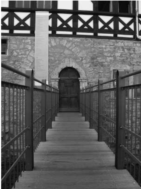
14 Bad Langensalza, Bergstr. 15. Nordansicht nach Sicherungsarbeiten 2006. – Bad Langensalza, 15 Bergstrasse, vue du côté nord, après travaux de restauration en 2006.
