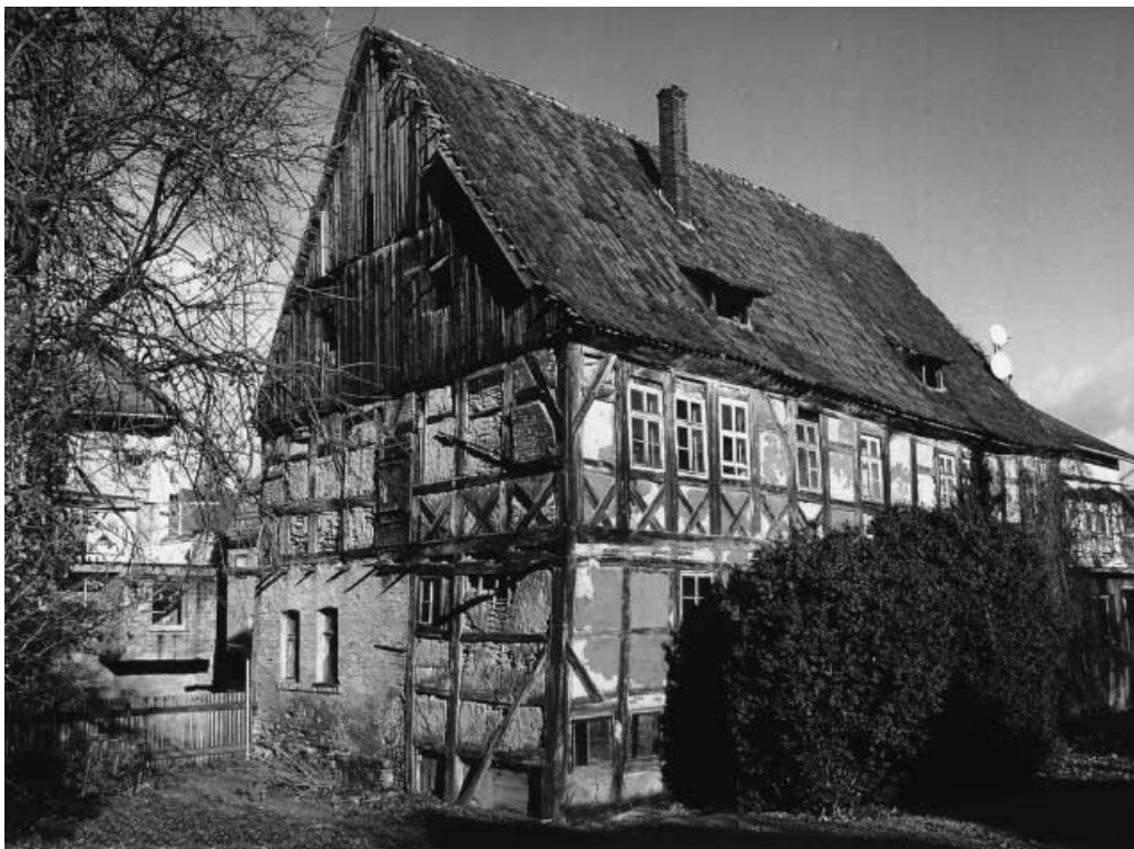
1 Bad Langensalza, Bergstr. 15, „Haus Rosenthal“ im Dornröschenschlaf, vor Beginn der Sicherungsarbeiten. – Bad Langensalza, 15 Bergstrasse: Haus Rosenthal. « La maison de la vallée des roses » avant le début des mesures de restauration.
